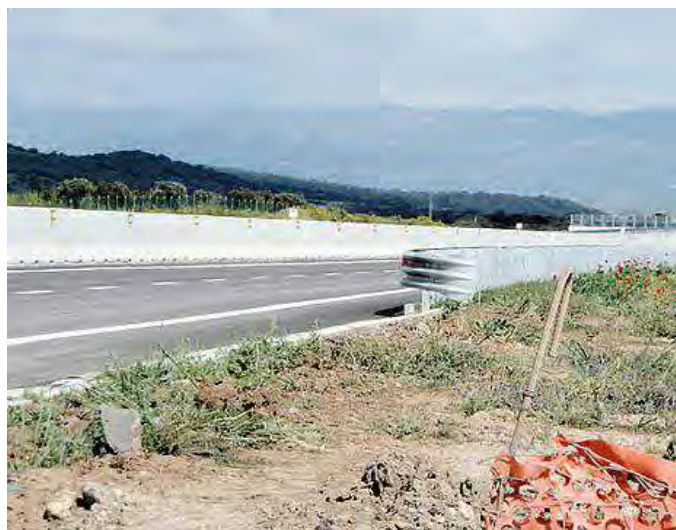
Uno dei cantieri sulla nuova quattro corsie tra Sassari e Olbia
